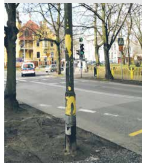
Ulica Felczaka - zaniedbane latarnie
