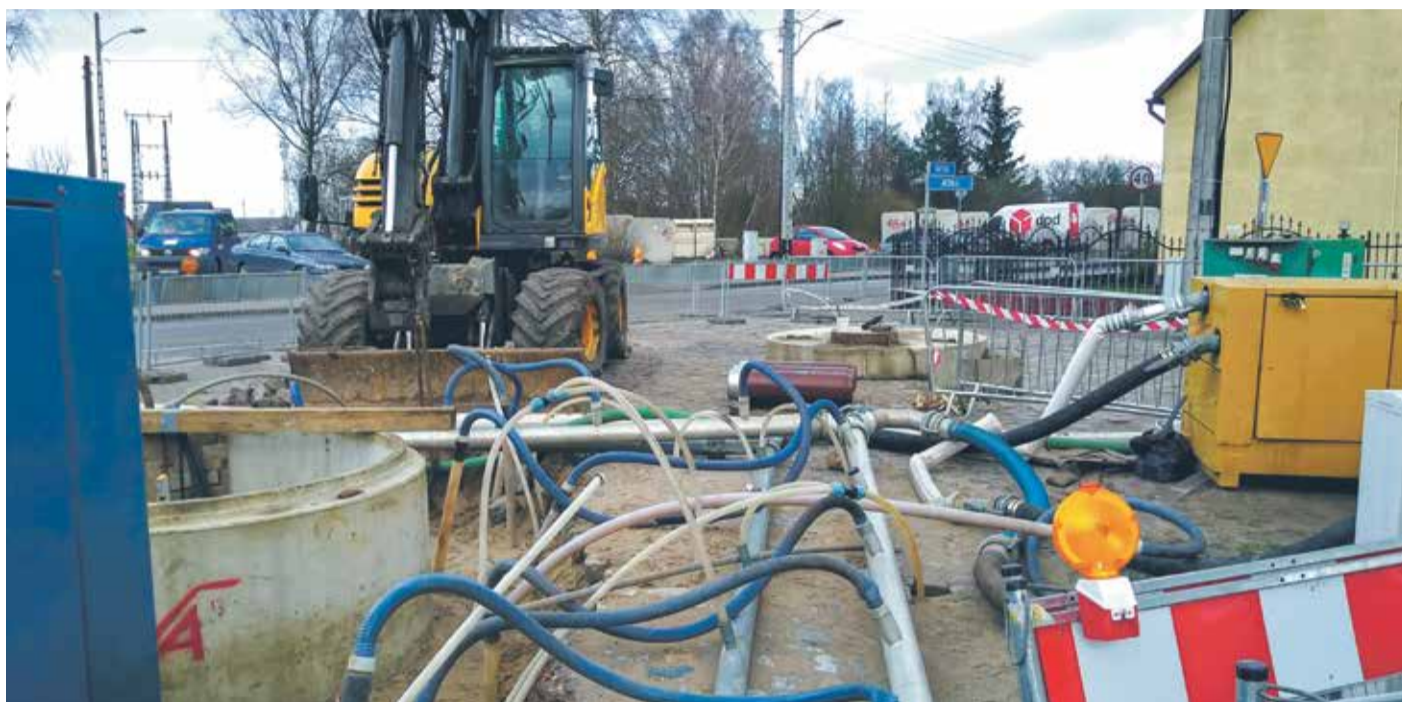
Prace przy ul. Bałtyckiej
