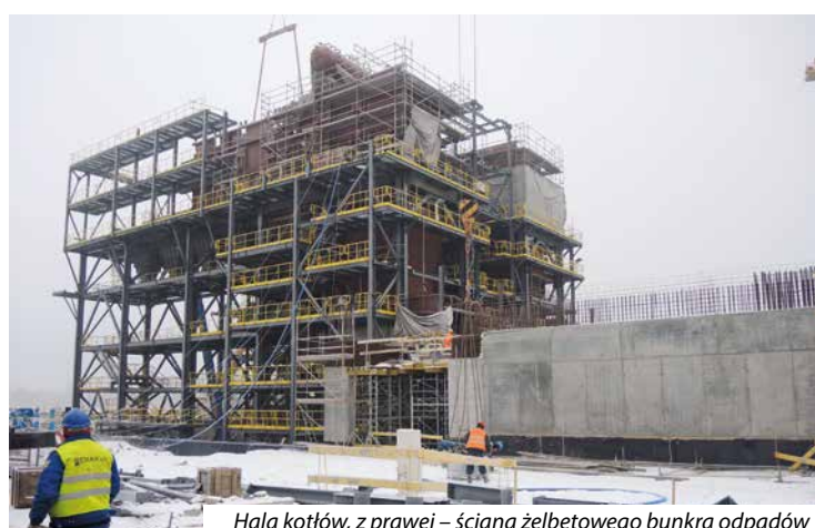
Hala kotłów, z prawej – ściana żelbetowego bunkra odpadów
