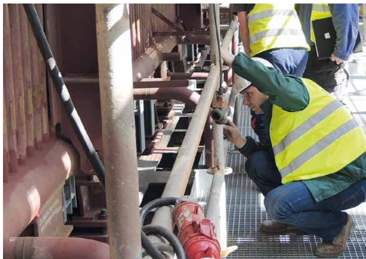
Damian Fiedorowicz z Urzędu Dozoru Technicznego 100 minut sprawdzał szczelność kotła. Na koniec ogłosił: próba zakończona z wynikiem pozytywnym!
