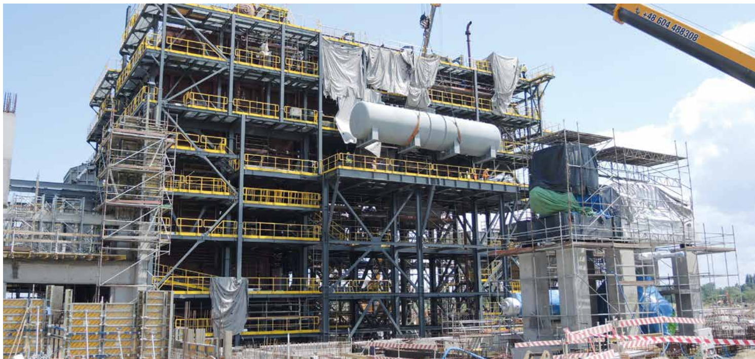
Hala kotłów. Tego samego dnia, w którym odbyła się próba ciśnieniowa, odbył się montaż zbiornika wody zasilającej kotły (to ten biały wielki cylinder w środku). Zbiornik będzie zabezpieczał kotły przed brakiem bieżącego zasilania w wodę. Wystarczy na godzinę pracy kotłów.
