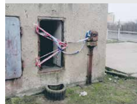
Drzymały. Niezabezpieczone wejście do bunkra.
