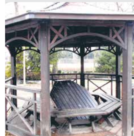
Uszkodzony stół w parku przy ul. Cichej.
