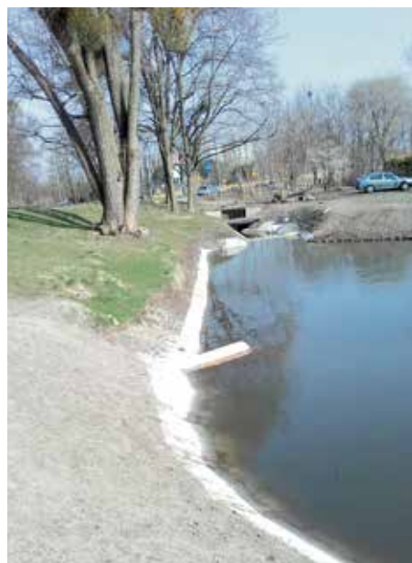
Remont stawu przy ul. Smutnej.
