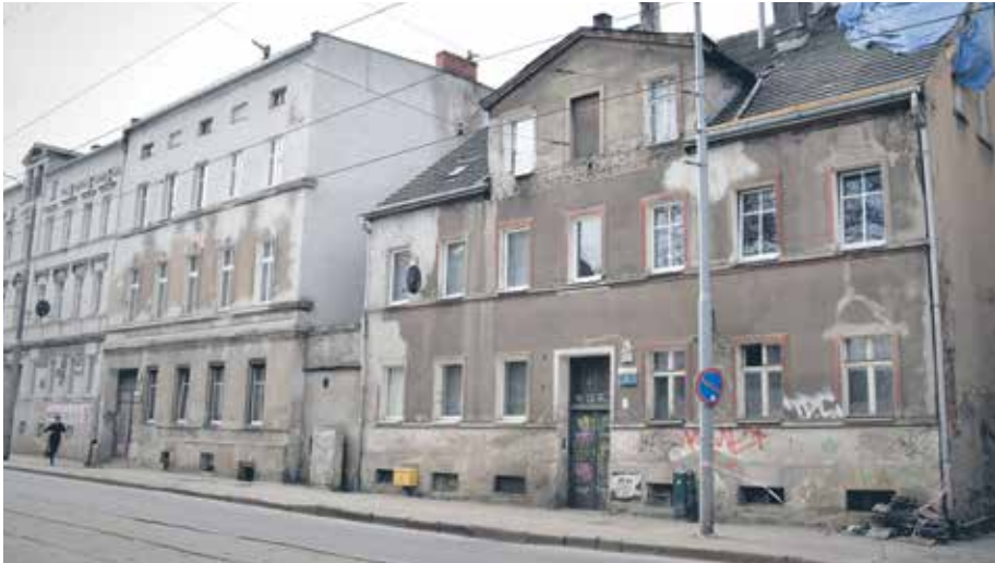
Kamienice przeznaczone do remontu.
